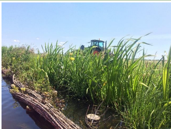
Figuur 6-1 voorbeelden van vaste beschoeiing in de veldwetering in Groot-Wilnis Vinkeveen. Links is de beschoeiing dicht op de kant gezet (1m) en functioneert goed om de oever te beschermen tegen golfslag en stroming, rechts is de beschoeiing ver uit de kant gezet (>3m) in diep water op een erosiegevoelig punt.
